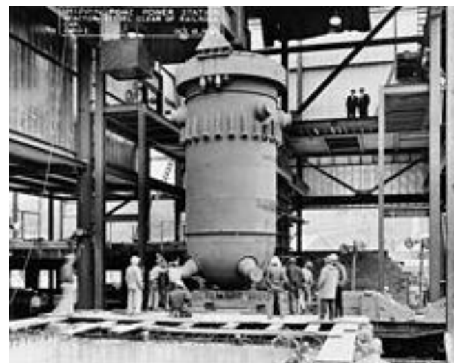
圧力容器 (厚さ22cm の 鋼鉄容器中に核燃料)
